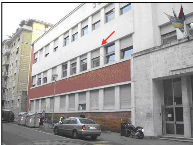
Fig. 1 – Posizionamento del microfono per la misura esterna.
