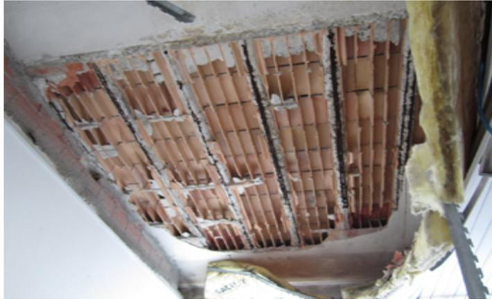
Fig.1 - Esempio di sfondellamento di solai.
